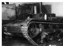
*Трофейный советский танк ХТ-26 на ремонтном заводе в Варкаусе, весна 1940 года. В передней части башни видна пробоина от противотанкового снаряда. В финской армии захваченные ХТ-26 использовались только как учебные машины, при этом огнеметы с них демонтировали (фото из коллекции Э. Муикку).*
