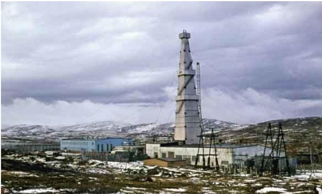
*Кольская экспериментальная опорная сверхглубокая скважина-самая глубокая горная выработка в мире, имеющая научное значение. В результате бурения, которое с перерывами велось с 1970 по 1991 год, глубина скважины составила 12 262 метра; диаметр верхней части-92 см, диаметр нижней части-21,5 см.*
