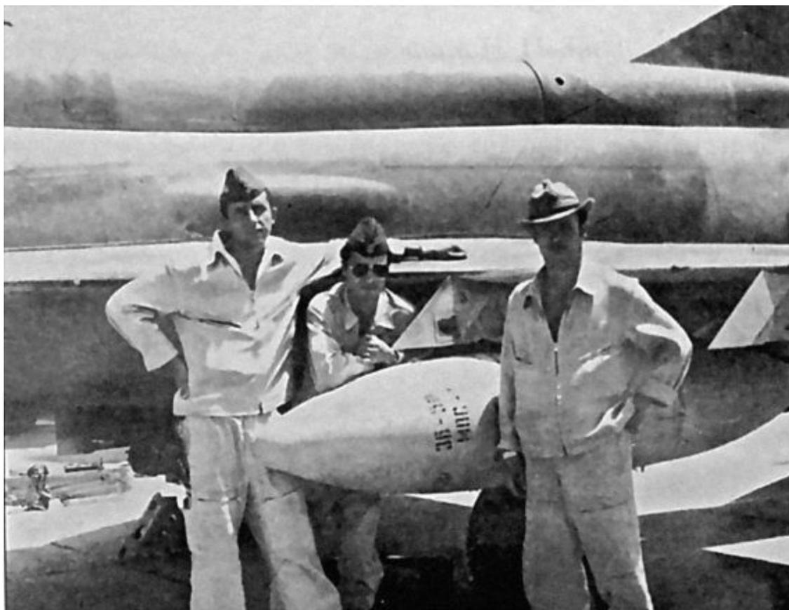
Подвеска зажигательных баков ЗБ-500 на самолете МиГ-21бис.
