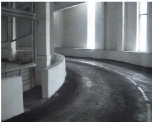
Устройство эпоксидного бесшовного покрытия на уклоне свыше 20 град. 147 Автобаза ГШ, г. Москва, 2004 г.
