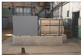
Защитное ограждение 2 БП длиной 2 м с монтажем металлоконструкции в опорный блок-фундаментный блок специального сечения
