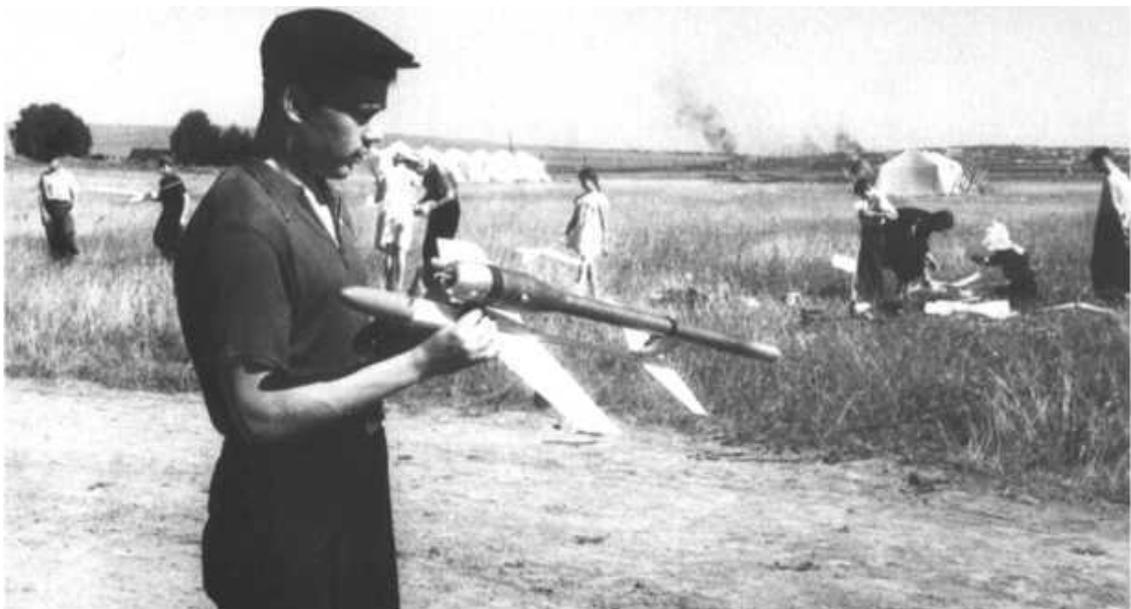
*26. Авиамодель с пульсирующим реактивным двигателем перед пуском.*
