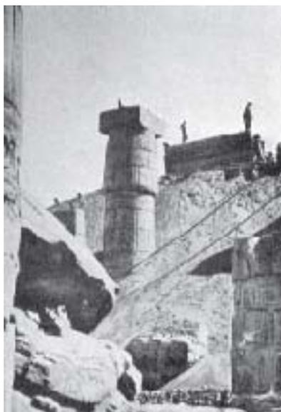
*Рис. 6. Карнак. Разборка колонны*
