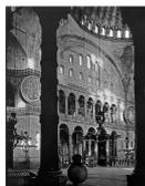
*Рис. 30. Грандиозный храм Святой Софии в Константинополе. Огромный купол диаметром 31,5 метра поддерживается сложной системой полукуполов. Взято из [643:2], с. 41*
