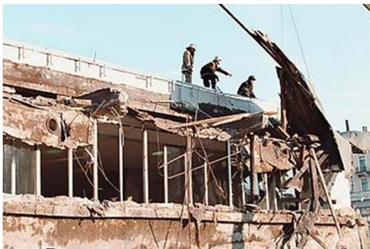
Рис. 10. Разрушение козырька над входом в станцию метро «Сенная площадь» (бывшая «Площадь мира») в Санкт-Петербурге в 1999 г.<sup>15</sup>
