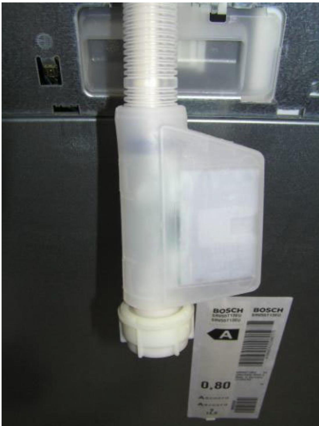
**Рис. 1.28.** Электромагнитный клапан системы Aqua-Stop
