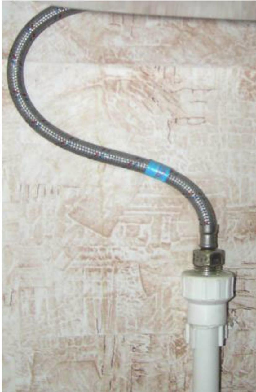
**Рис. 1.32.** Резьбовое подключение входного гидроконтра с помощью переходного шланга
