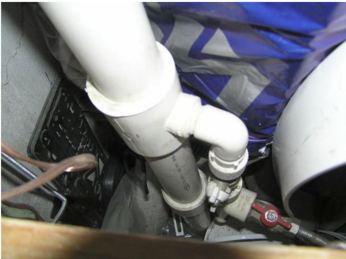
**Рис. 1.13.** Отвод от полипропиленовой трубы стояка
