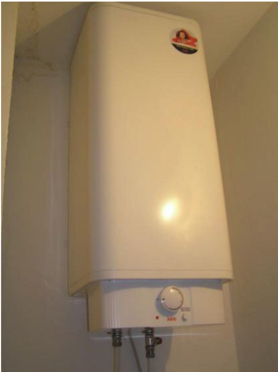
**Рис. 1.18.** Бойлер фирмы АЕГ объемом 100 л накопительного типа для автономного обеспечения горячей водой
