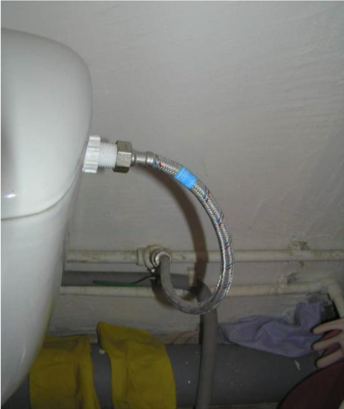
**Рис. 1.15.** Подводка холодной воды к бачку унитаза «Компакт»
