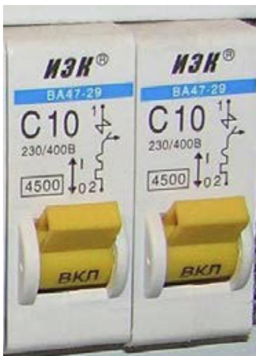
**Рис. 1.26.** Рекомендуемый автоматический предохранитель-выключатель с функцией срабатывания защиты при появлении токов утечки; устанавливается на каждый провод
