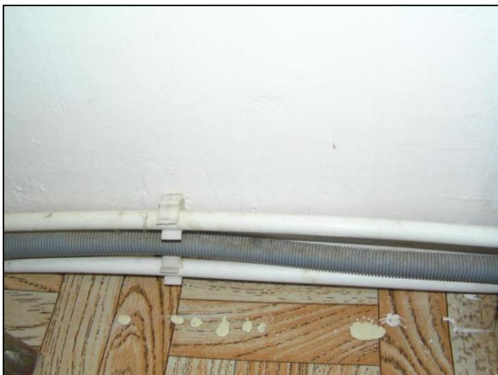
**Рис. 1.6.** Полипропиленовые трубы подвода горячей и холодной воды
