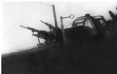
*Ил-2 АМ-38 (зав. № 1013) производства завода № 18 с двумя неподвижными пулеметами ШКАС для стрельбы назад.*
