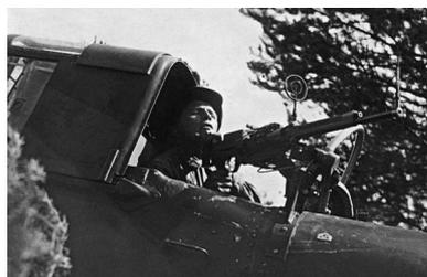
*Установка оборонительного пулемета LLKAS на самолете Ил-2, смонтированная силами технического состава 243 шад 6 ВА в августе 1942 г. Всего в дивизии было оборудовано такой установкой 10 Ил-2 в 288 шад и 9 – в 74 шад*
