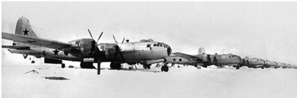
*Бомбардировщики Ту-4 на северном аэродроме. Для транспортировки и применения первых советских атомных бомб была разработана модификация самолёта Ту-4, получившая обозначение Ту-4А (атомный). Самолёт был оборудован термо-стабилизированным бомбоотсеком с электрообогревом и электронной системой управления. Была разработана система подвески бомбы, а также приняты меры биологической защиты экипажа в полёте*
