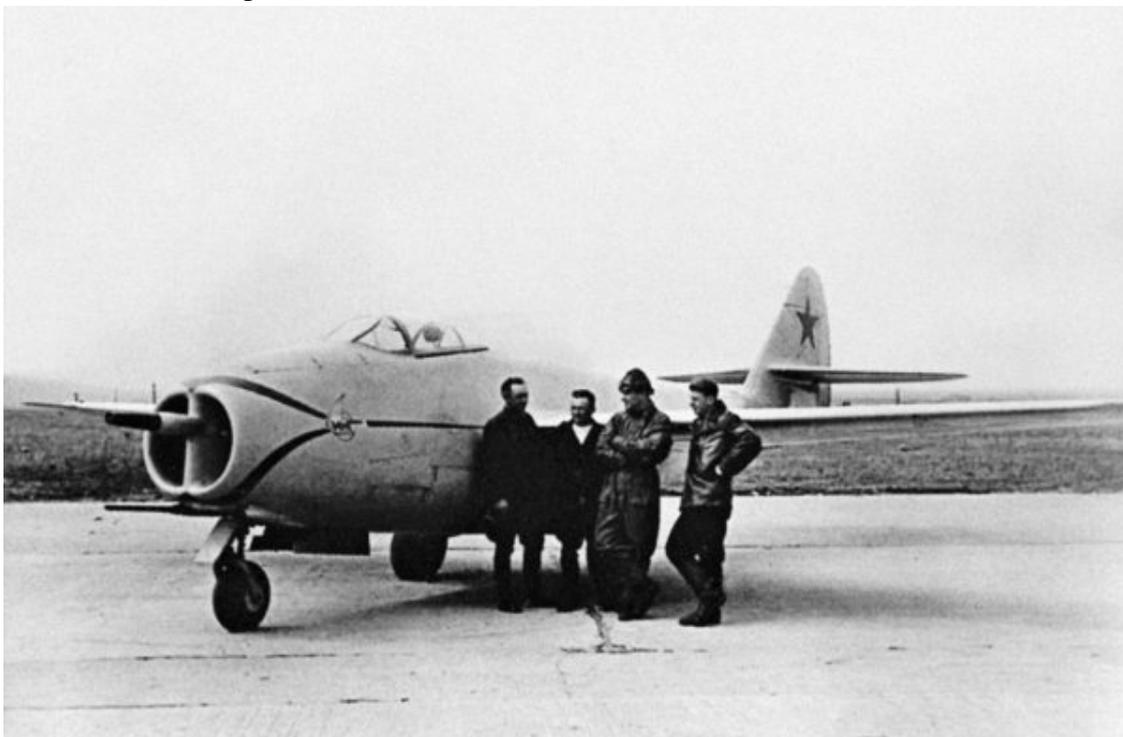
И-300 — первый прототип истребителя МиГ-9 с газотурбинными двигателями и участника его испытаний
