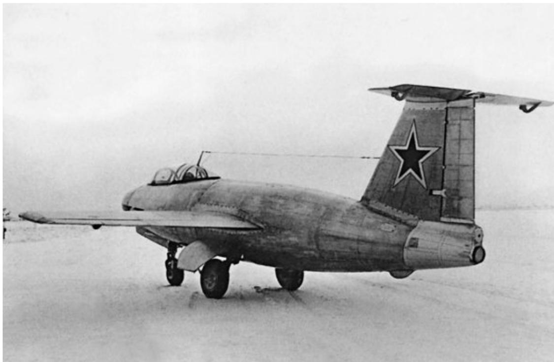
Опытный ракетный перехватчик И-270 с ЖРД
