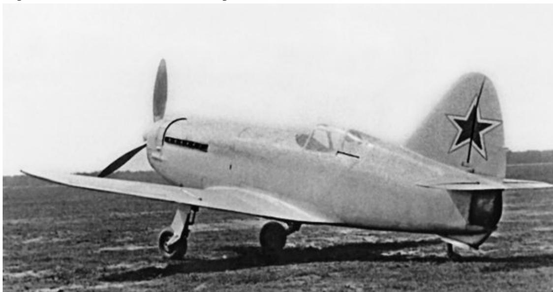
Опытный истребитель И-250 с комбинированной силовой установкой, включавшей маршевый поршневой мотор ВК-107А и воздушно-реактивный компрессорный двигатель (ВРДК)
