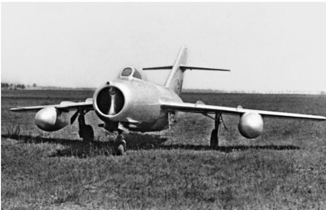
Истребитель сопровождения МиГ-15Сбис отличался подвесными топливными баками увеличенной емкости
