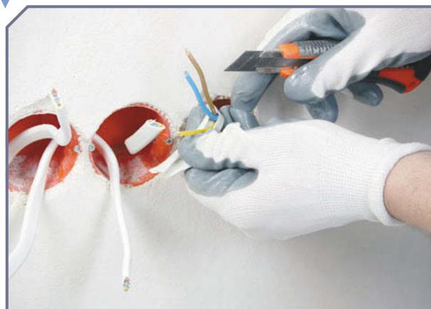
**4.** Зачищенные провода согните в кольцо диаметром 4—5 мм и подсоедините их к контактам, надежно затянув винтом. Старайтесь не затягивать слишком сильно, чтобы не передавить провод.
