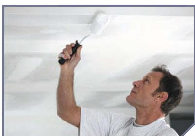
**6.** Начните с потолка, двигаясь от окна к противоположному концу комнаты. Потолок нужно красить полосами так, чтобы каждая следующая полоса немного заходила на предыдущую. При этом удобно использовать лестницу или специальную телескопическую ручку.
