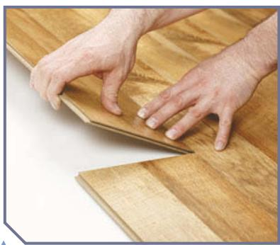
**4.** Доски ламината соединяются между собой специальными замками по принципу «шип — паз». Начните работу с угла у окна комнаты. Положите первую доску, а затем заведите вторую в торцевой замок под углом 20° и опустите ее на пол. При этом должен раздаться щелчок, который означает, что замки состыкованы правильно.
