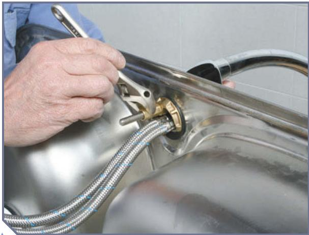
**7.** Вкрутите резьбовые штыри в основание смесителя через специальные отверстия. Не закручивайте их очень сильно, чтобы не сорвать резьбу.
