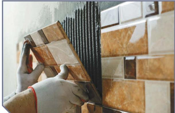
1. Перед укладкой плитки тщательно подготовьте поверхность стены. Приложите уровень и убедитесь, что просвет не превышает 2 мм. Простучите поверхность, чтобы проверить ее на прочность. Затем приготовьте жидкий раствор цемента с водой и нанесите его на стену. К облицовке можно приступать, когда раствор полностью высохнет.
