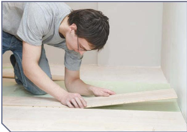
**7.** Лучше всего укладывать ламинат вразбежку. Закончите первый ряд, подрезав последнюю доску. Отмерьте необходимую длину на новой доске, сделайте разметку с помощью строительного уголка и отрежьте нужную часть лобзиком или пилой. Укладку второго ряда начинайте с оставшегося куска.
