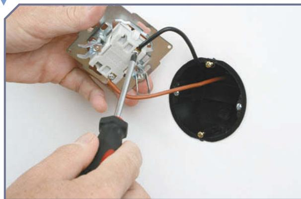
**5.** Если есть заземляющий провод, подсоедините его к соответствующей клемме заземления. Она соединяется с заземляющими усиками.
