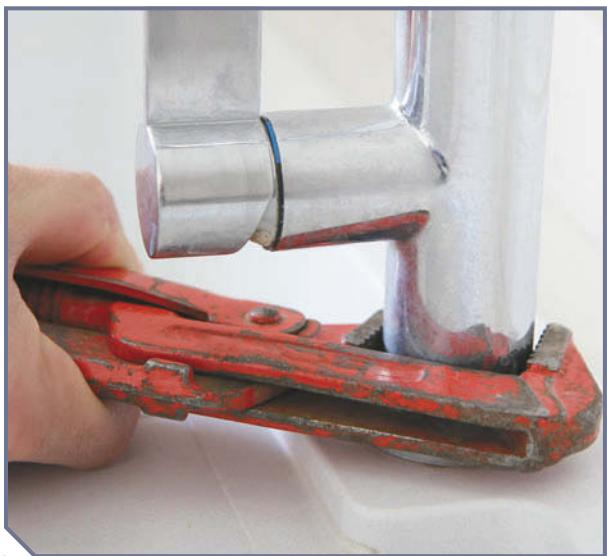
**8.** С помощью разводного ключа затяните монтажные гайки. Нужно приложить достаточно большое усилие, чтобы смеситель надежно стоял на своем месте и не прокручивался.
