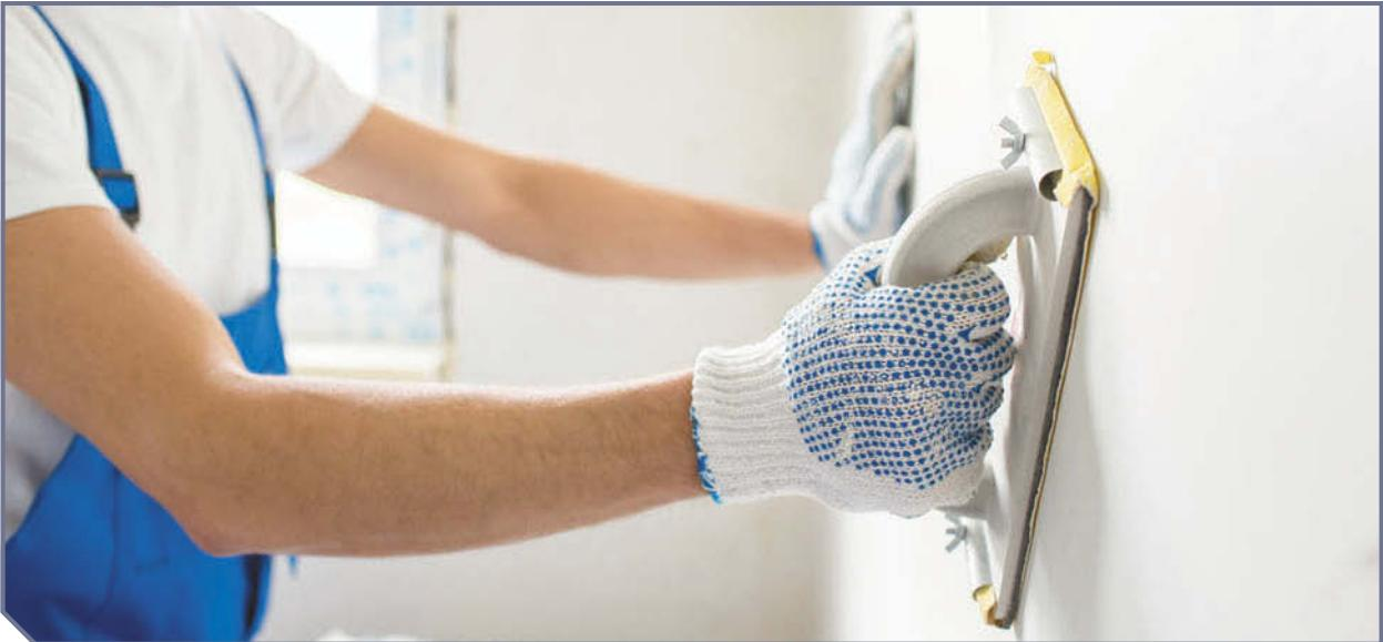
**1.** Подготовьте стены к окраске: очистите их от грязи и пыли, снимите слой старой краски, зашпаклюйте вмятины, трещины и царапины, а затем выровняйте поверхность мелкой наждачной бумагой.
