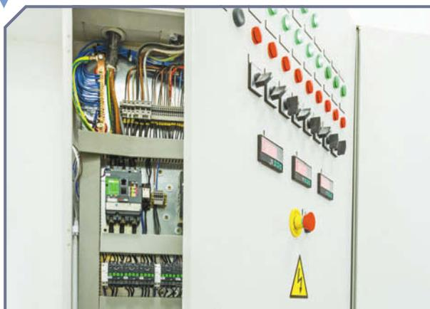
**2.** Убедитесь в отсутствии напряжения. Используйте для этого указатель напряжения или мультиметр.
