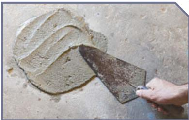
**1.** Тщательно подготовьте пол, потому что укладывать ламинат можно только на ровную и очищенную от мусора поверхность. В полу не должно быть глубоких трещин, выбоин и перепадов высоты более 2 мм на 1 м<sup>2</sup>.
