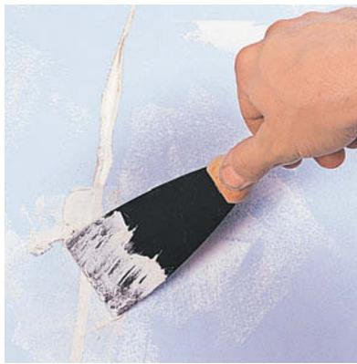
**Вдавите шпаклевку в трещину гибким шпателем**
