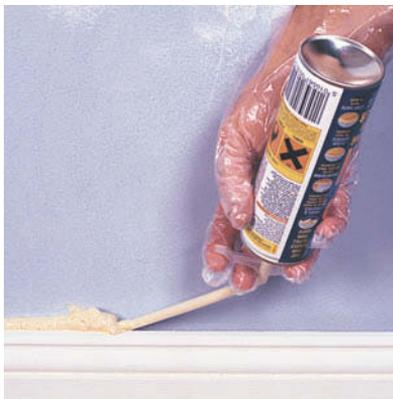
**Большие зазоры можно заделать монтажной пеной**
