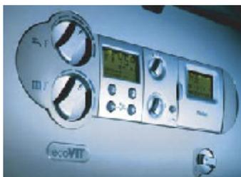
Рис. 6. Панель управления котла
