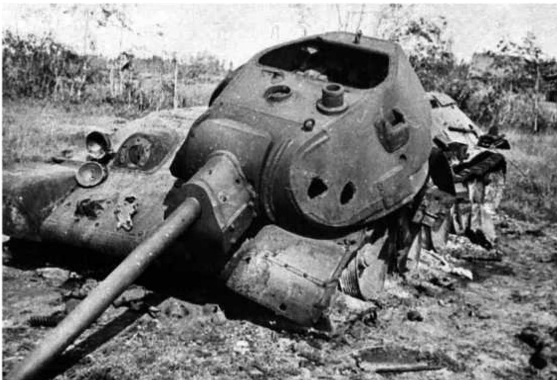
*Т-34, подбитый в районе Можайска. Судя по размеру пробоин, танк стал жертвой 88-мм зенитки*
