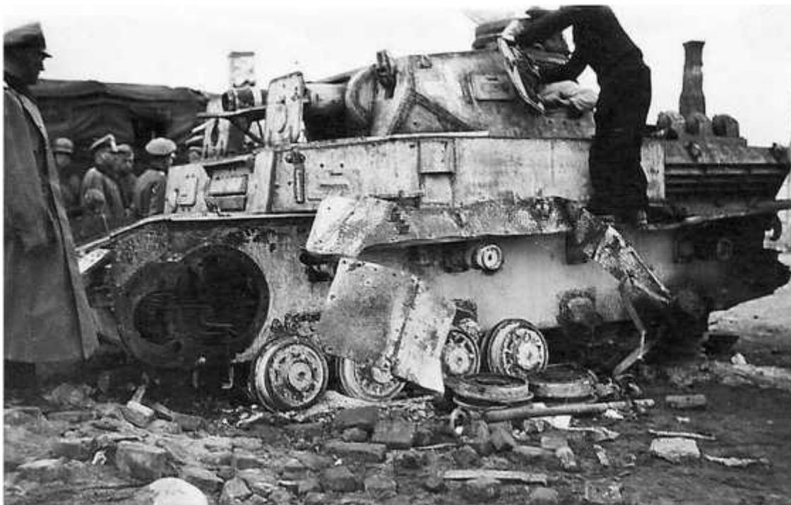
*Что еще можно открутить? Процесс «каннибализации» подбитого немецкого Pz.IV. Бортовые передачи и орудие уже сняты*
