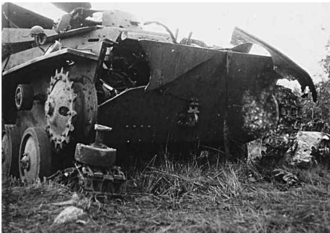
*Разбитый танк Т-40. Тонкая броня формально считающейся новой машины достаточно легко разрушалась под огнем противника*
