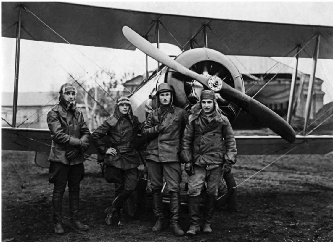
В. П. Чкалов (крайний справа) у истребителя «Ньюпор-XXIV» Длина самолета – 5,85 м, размах крыльев – 8,16/7,76 м, площадь крыльев – 15 м<sup>2</sup>. Практический потолок – 6800 м.
