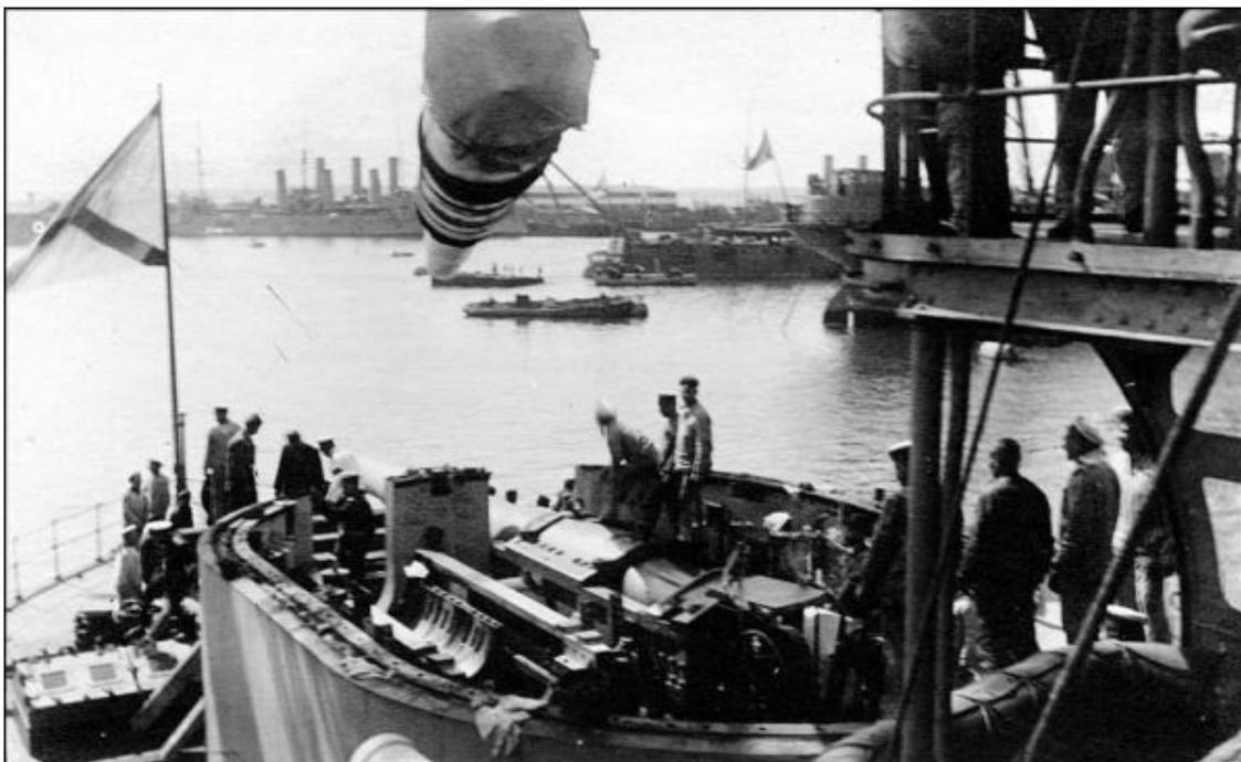
*Замена 12-дм орудий на «Славе» (Кронштадт, октябрь 1909 г.). На фото запечатлены два момента установки нового орудия ОСЗ МА № 78 в кормовую баиню линкора.*
