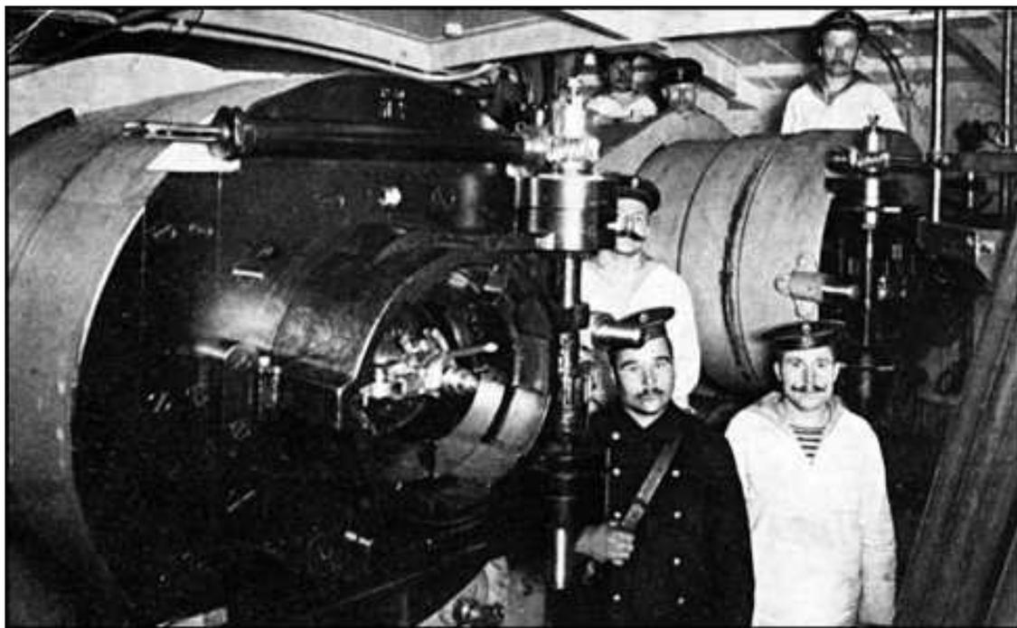
*В носовой 12-дм башне «Славы» после замены орудий в 1909 г. На переднем плане – орудие ОСЗ МА № 81, оснащённое затвором усовершенствованной конструкции системы Обуховского завода*
