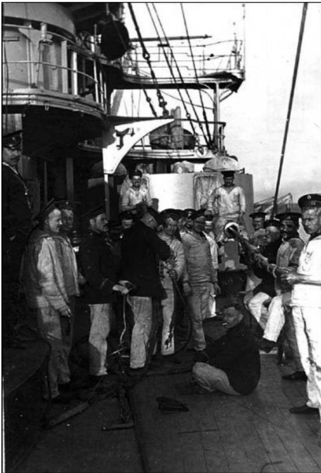
*Обслуживание 6-дм орудия левой носовой башни правого борта (нанесение смазки после банения). На палубе виден трос, с помощью которого проводилось машинное банение*
