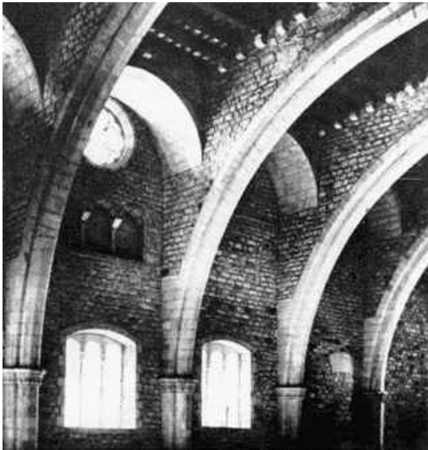
*Плоское деревянное перекрытие потолка в системе опорных арок (фрагмент). Зал ста в ратуше*
