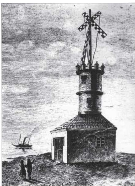
В 1794 г. во Франции Клод Шапп построил первый оптический телеграф между Парижем и Лиллем (225 км), состоявший из цепочки вышек с поворотными сигнальными переключателями. При хороших погодных условиях, разворачивая переключатели в соответствии с кодом, можно было передать информацию по всей цепочке за 15 минут. Условная азбука телеграфа содержала 250 сигналов для 8464 слов, расписанных на 92 страницах, по 92 слова на каждой. Эта система не устарела до самого изобретения электрического телеграфа.
