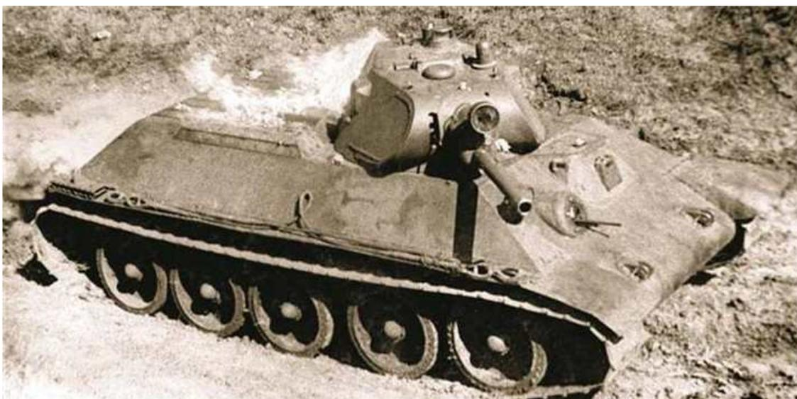
Советский танк А-34 – прототип легендарного Т-34 на испытаниях. Весна 1940 года. Забрасывание моторного отсека бутылками с горючей смесью
