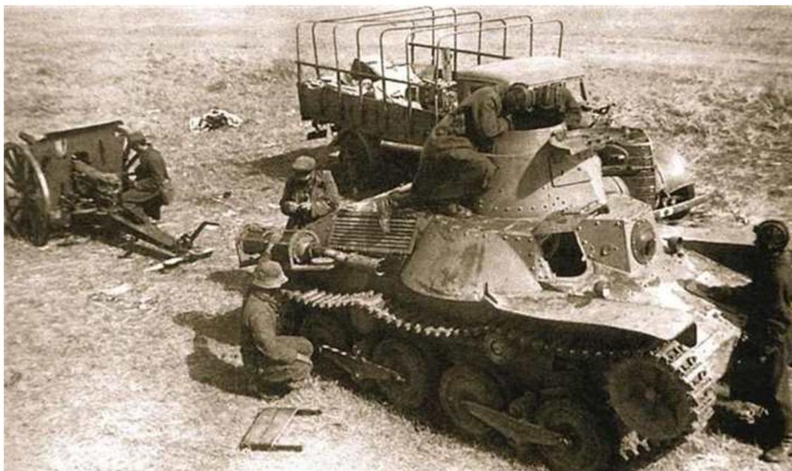
Красноармейцы обследуют брошенную японскую технику после боев на реке Халхин-Гол. На переднем плане – легкий танк Тип 95 «Ха-Го». Боец слева осматривает 75-миллиметровое орудие, «улучшенный тип 38», основное полевое орудие Квантунской армии в боях на Халхин-Голе. Несмотря на архаичную конструкцию, это орудие благодаря своему небольшому весу, продержалось в японской армии вплоть до конца войны
